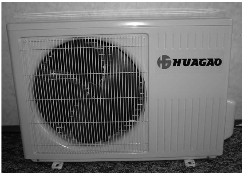
Рис. 3.2. Наружный блок кондиционера Hуаgаo KFR25W/SV с общим весом 36 кг
