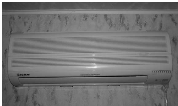
Рис. 3.8. Конечный вид установленного на панели крепления внутреннего блока кондиционера Huagao KFR25W/SV.
