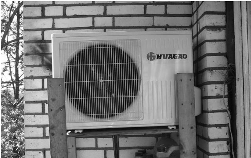
Рис. 3.3. Способ установки выносного блока непосредственно на лоджии
