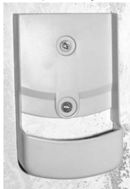
Рис. 3.20. Вид на панель крепления, смонтированную на стене при входе в жилое помещение
