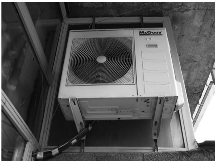
Рис. 3.11. Вид подключенного наружного блока при выводе патрубков и силового кабеля через «естественное» отверстие (без сверления стены)
