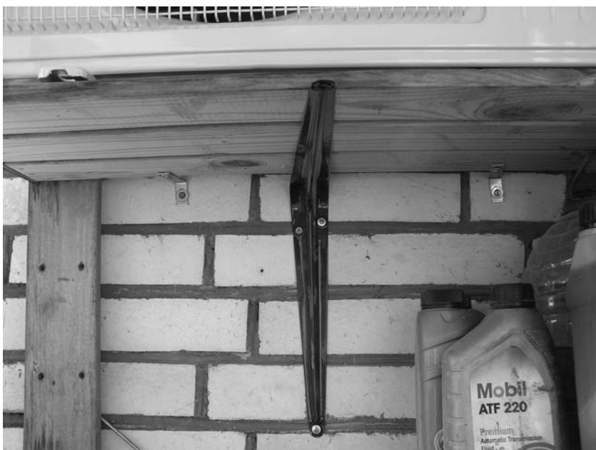
Рис. 3.4. Метод установки консолей на лоджии
